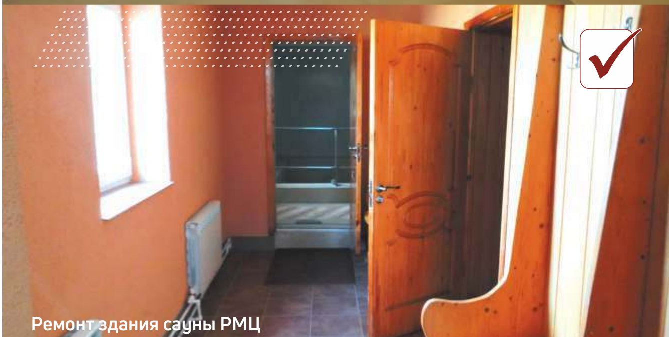
Реконструкция и ремонт КПП 1
