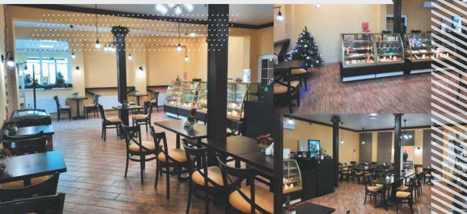
Реконструкция и ремонт кафетерия на смотровой площадке
